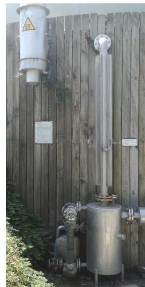
Figuur 1: voorbeeld van koelvinnen voor het ontwateren van het biogas.
