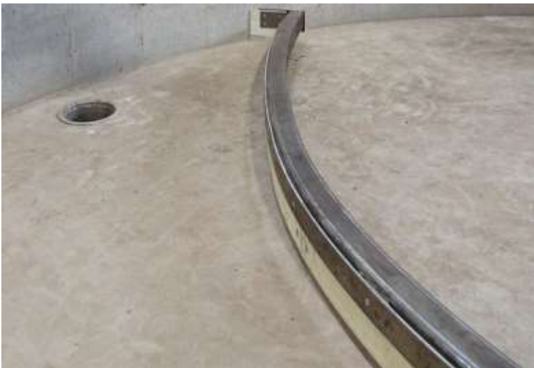
Figuur 2: Voorbeeld van een grondschraper/bodemkrabber (Bron: http://www.biogas-hochreiter.de/en/sand-scraper/ ).
