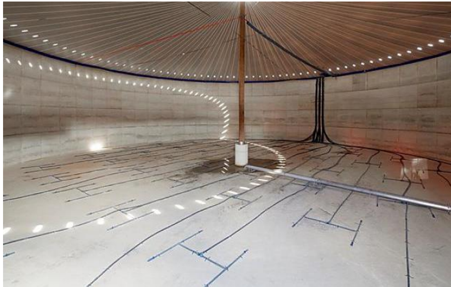
Figuur 12: Tyleenslangen onderaan de mestkelder bij het Aeromix-systeem
